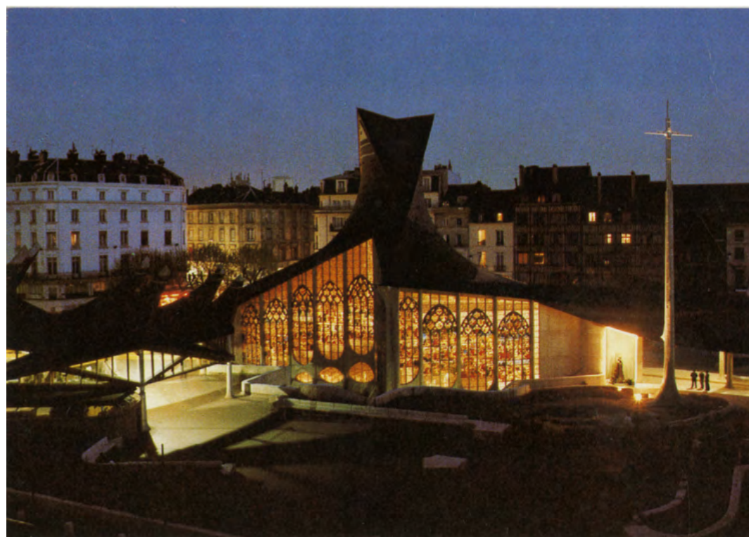
De haut en bas : Couvent Sainte-Marie de La Tourette, Eveux [69], Le Corbusier arch. © DR. Sainte-Jeanne d'Arc, Rouen [76], L. Arretche arch, 1963-79. © Académie d'architecture/CAPA/AA XX ème .
