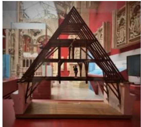
Huit chevrons de la charpente du chœur. Vers 1220 .
